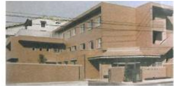
更生保護施設の外観
